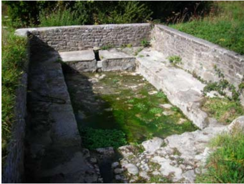
Lavoir situé en amont de la plage
