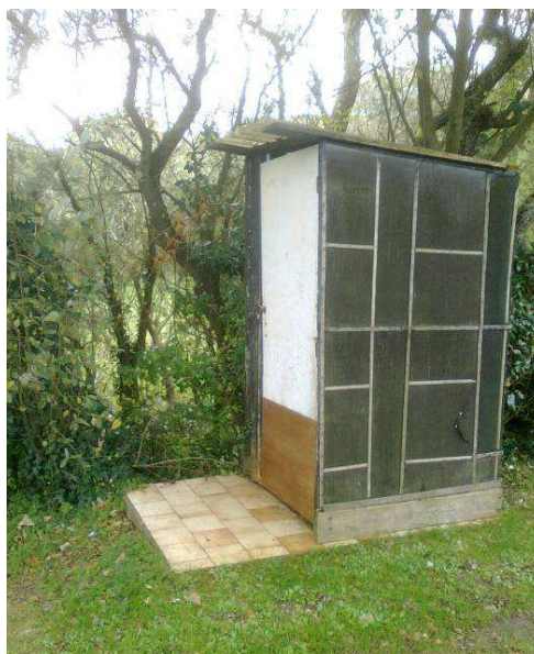
Sanitaire aménagé dans le vallon de Porsliogan à moins d'1 mètre du ruisseau
