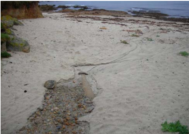
Pors ar Goret - Photographie prise le 30 septembre 2010 Exutoire pluvial qui débouche en partie haute de l'estran
