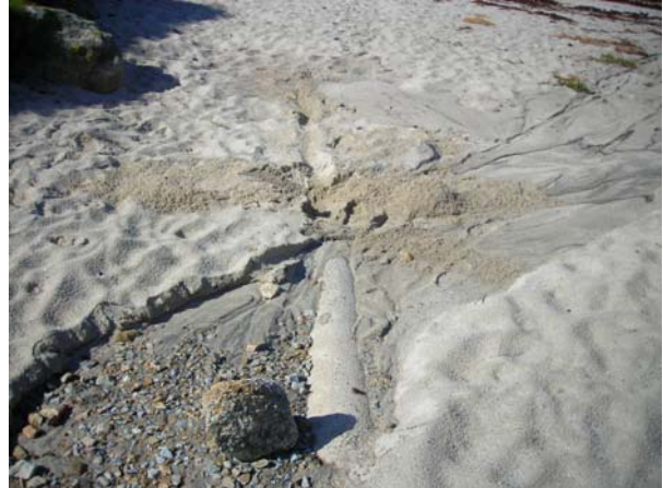
Pors ar Goret - Photographie prise le 30 septembre 2010 Exutoire pluvial qui débouche en partie haute de l'estran
