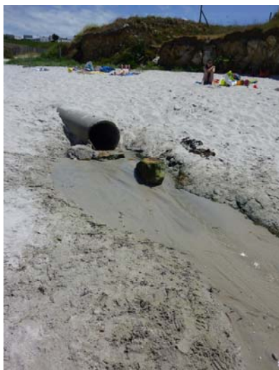
Exutoire du ruisseau de Porsévigné
