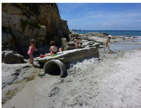
L'émissaire a subi les assauts de la mer dans sa partie intermédiaire
