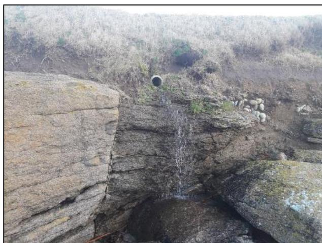
**Photo 10 : Exutoire n°3 présentant un écoulement en temps sec (source : LABOCEA)**
