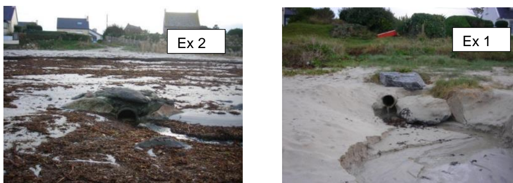
Figure 28 : Exutoires EP présents sur la plage de Pors ar Vilin Vras
