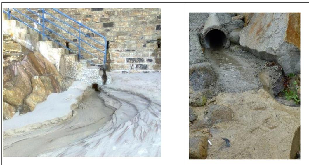
***Figure 31 : Exutoires d'eaux pluviales de la plage de Portez en contrebas de l'escalier de la cale***
