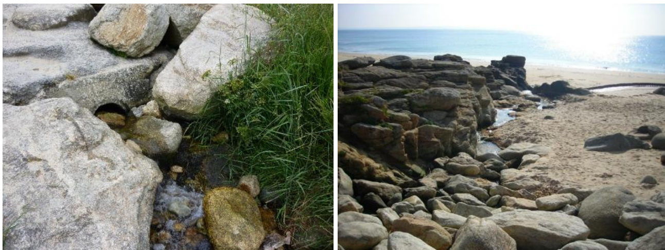
Photo 1 : Exutoire du ruisseau de Portez
