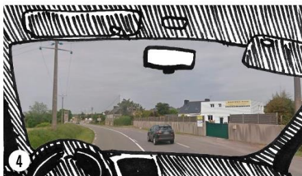
4 Réseau électrique et zone d'activités
