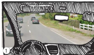
1 Caractère autoroutier de la D 789 (calibrage et glissière)
