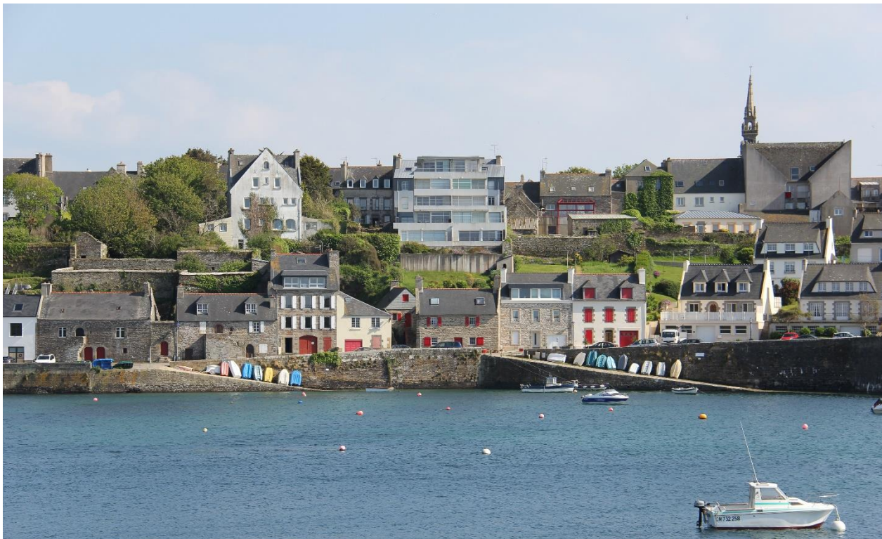
Le front portuaire du Drellac'h au Conquet et son dispositif de cales: un ensemble bâti d'intérêt patrimonial maritime.
